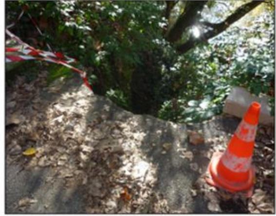
*Affaissements des berges du Tarn, en bordure du parking des berges, ayant provoqué le décalage du parapet (à gauche) et la disparition d'une partie de la chaussée (à droite) [Source : IMS<sup>RM</sup>]*
