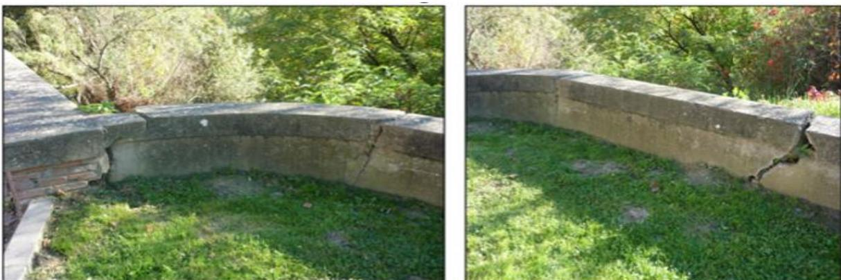
*Affaissements des berges du Tarn, en bordure du Cours Foucault, ayant entraîné des ruptures et des décalages de parapets [Source : IMSRM]*
